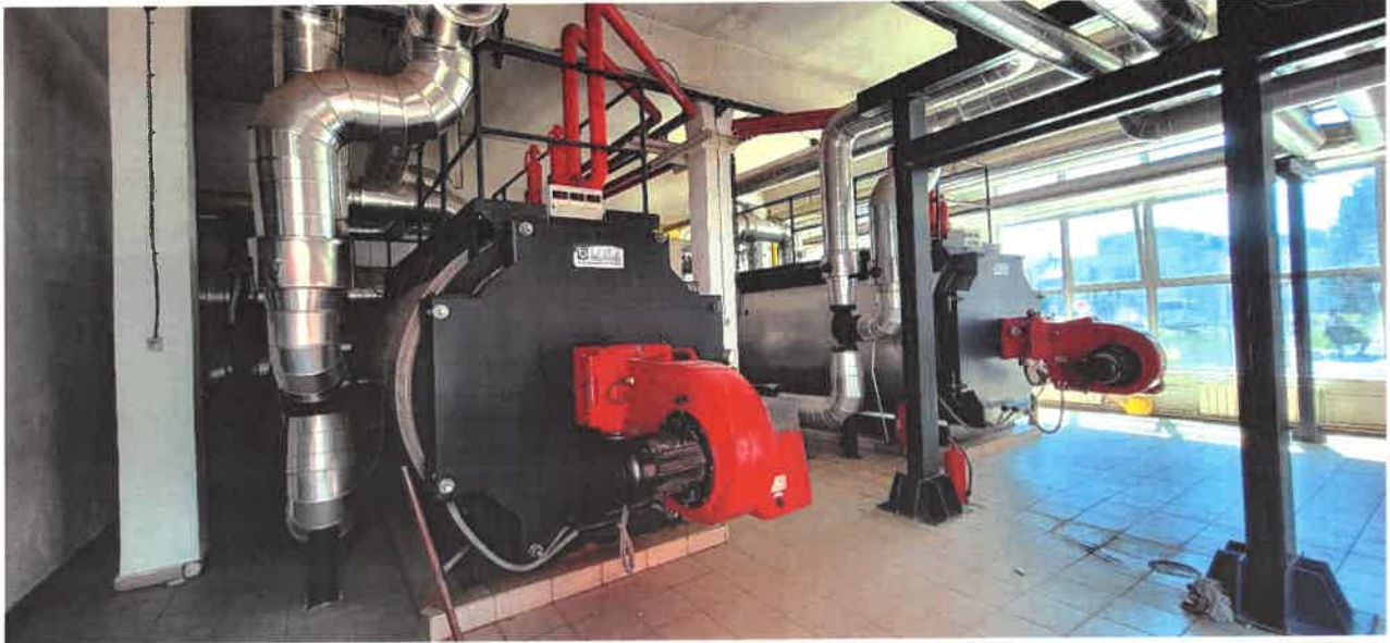
Fig. 2.14. CT 2, echipată cu 4 cazane LOOS tip UT-WT-5200 – 4000 kW fiecare
