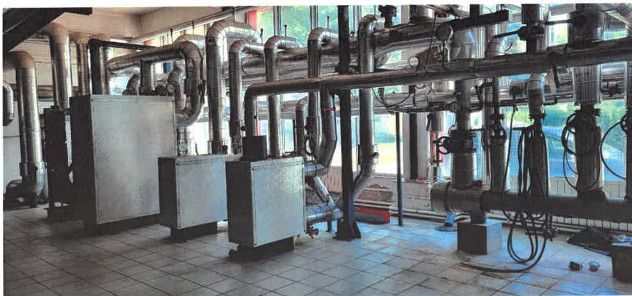
Fig. 2.12. CT 1, echipată cu 3 cazane LOOS tip UT-WT-5200 – 4000 kW fiecare
