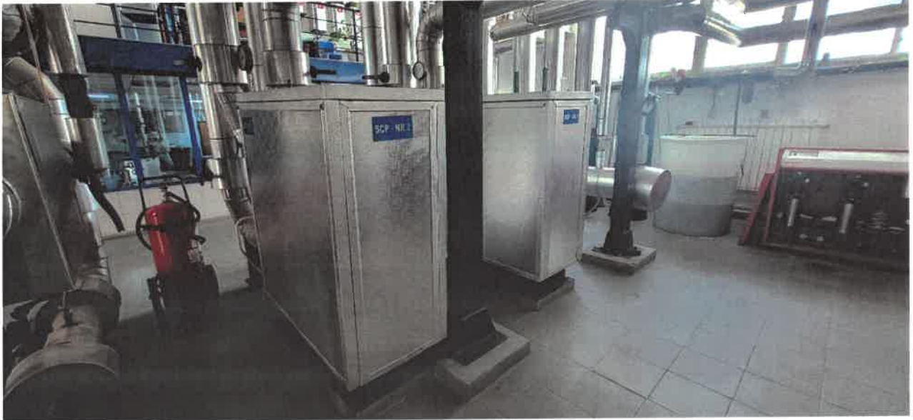
Fig. 2.20. CT 5, echipată cu 3 cazane LOOS tip UT-WT-5200 – 4000 kW fiecare
