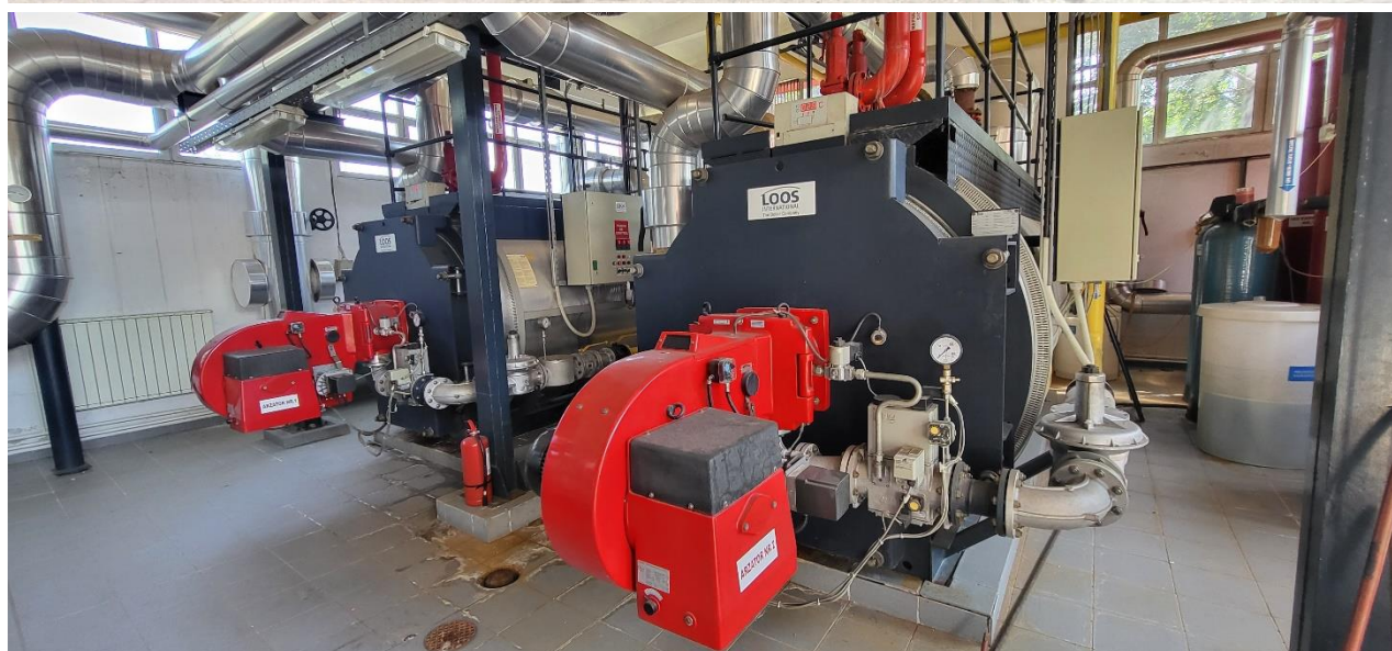
Fig. 2.24. CT 8, echipată cu 2 cazane LOOS tip UT-WT-4150 – 3700 kW fiecare
