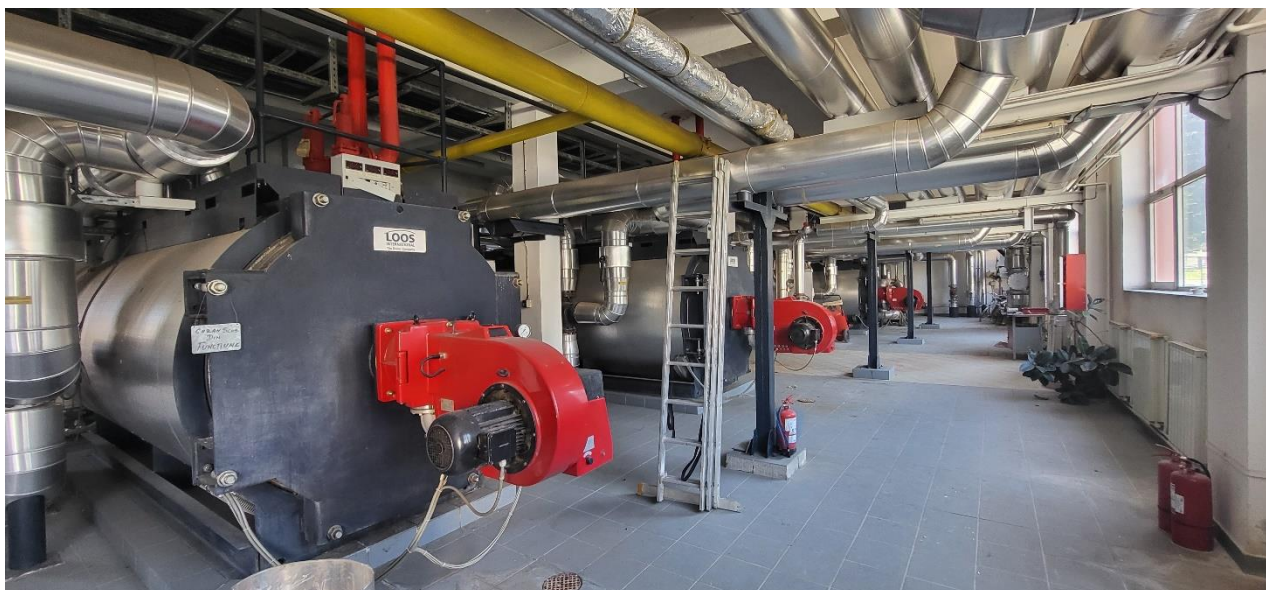
Fig. 2.16. CT 3, echipată cu 3 cazane LOOS tip UT-WT-5200 – 4000 kW fiecare
