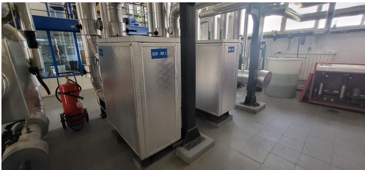
Fig. 2.20. CT 5, echipată cu 3 cazane LOOS tip UT-WT-5200 – 4000 kW fiecare
