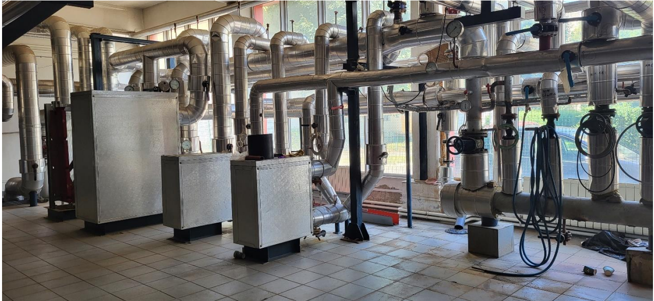
Fig. 2.12. CT 1, echipată cu 3 cazane LOOS tip UT-WT-5200 – 4000 kW fiecare
