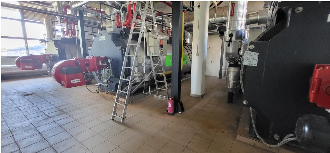
Fig. 2.18. CT 4, echipată cu 3 cazane LOOS tip UT-WT-5200 – 4000 kW fiecare
